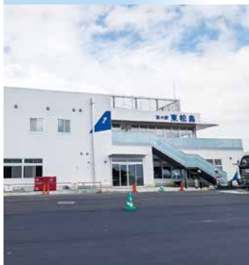
▲現在の道の駅の工事の進捗状況
