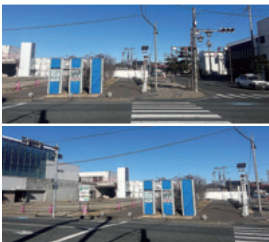
▲現在実施している矢本駅周辺整備事業
