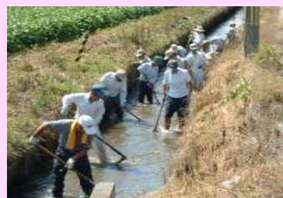
水路の泥上げ
