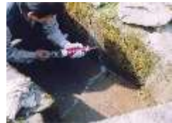
水路のひび割れ補修
