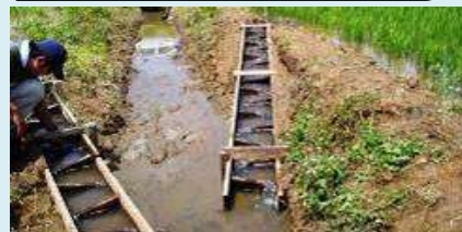
水田魚道の設置
