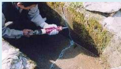
水路のひび割れ補修
