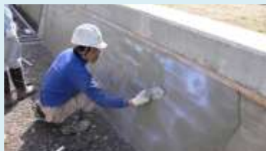
老朽化した水路壁のコーティング
