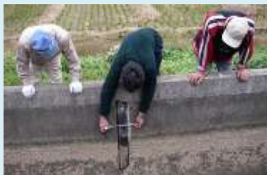
施設の機能診断
