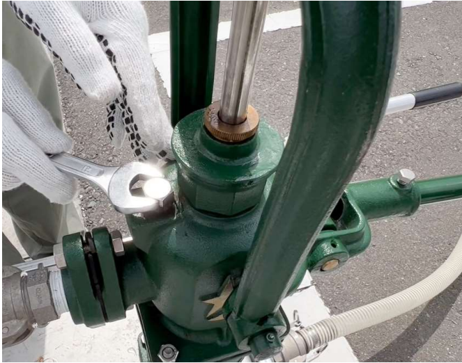
⑦吐き出し用ホースから水が出るまでポンプのレバーを上下する
