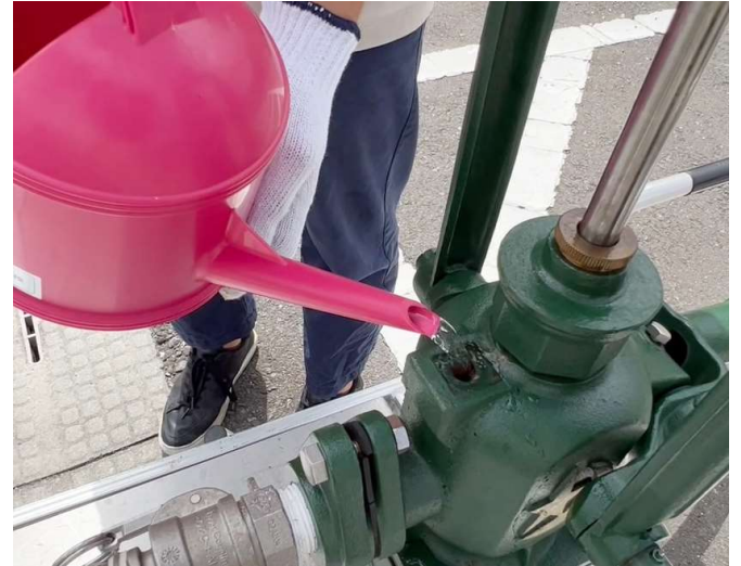
⑥外したネジ穴にじょうろ等で約2Lの水を入れる（水を入れたらネジを締める）
