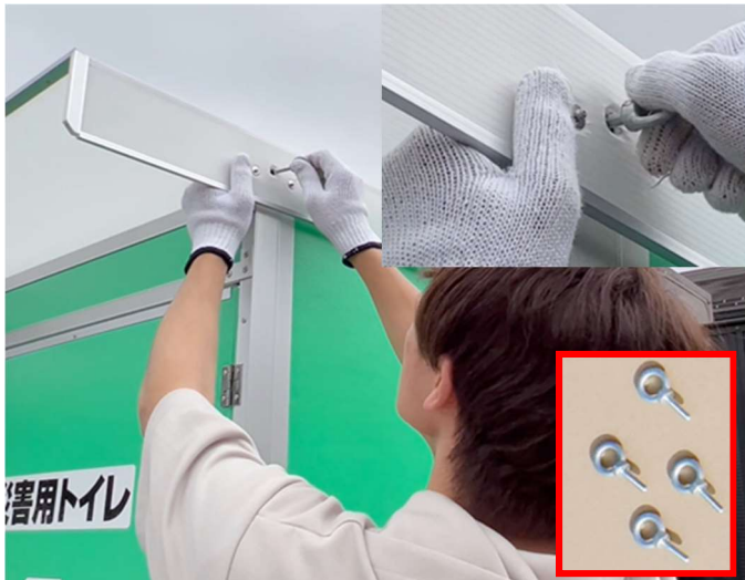
⑦屋根四隅をアイボルトで固定する
