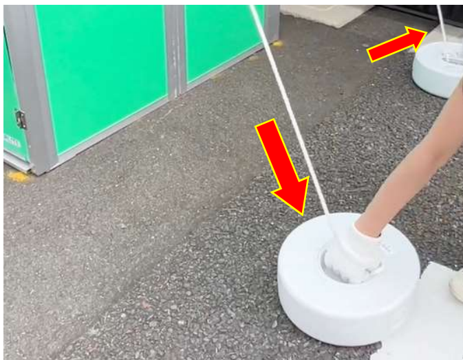
⑨ロープの反対側を重石に結び、ロープを張る
