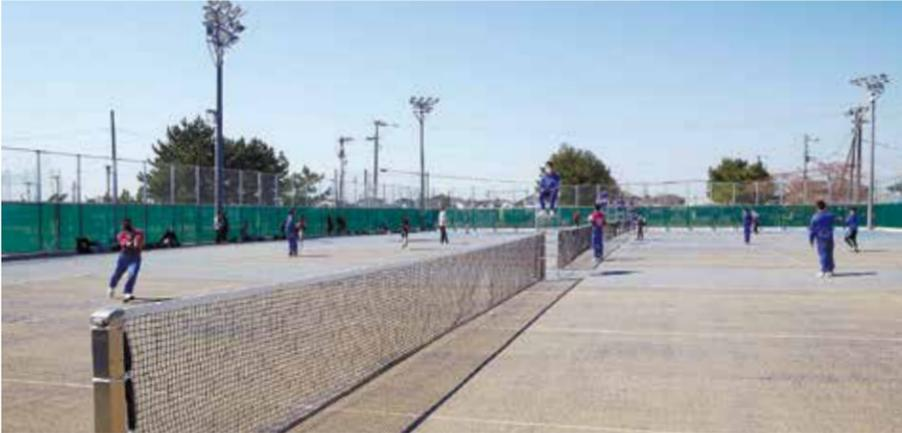
矢本運動公園テニスコートは、昭和59年の整備後38年が経過し、施設の老朽化が進み改修が必要なことから、「松島飛行場周辺民生安定施設整備事業」の採択を受け、改修工事を行いました。テニスコートは4面あり、2740㎡を全天候型砂入り人工芝コートに改修したことで、水はけの改善と球の弾みの安定、利用者の足腰への負担軽減を図りました。また、ナイター照明のLED化、出入り口にスロープを設置しバリアフリー化を図り障害のある人や高齢者などが快適に足を運べるよう整備しました。
