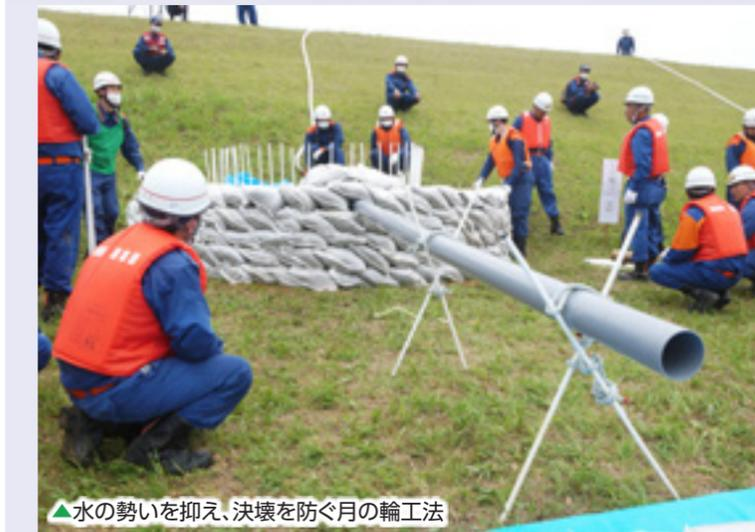
▲水の勢いを抑え、決壊を防ぐ月の輪工法
