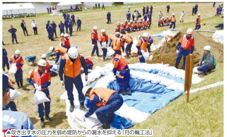
▲吹き出す水の圧力を弱め堤防からの漏水を抑える「月の輪工法」
