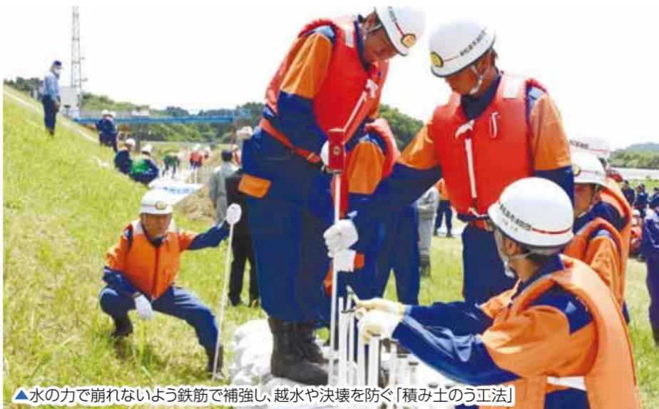
▲水の力で崩れないよう鉄筋で補強し、越水や決壊を防ぐ「積み土のう工法」
