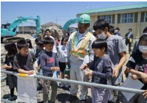
▲学校解体現場も見学
