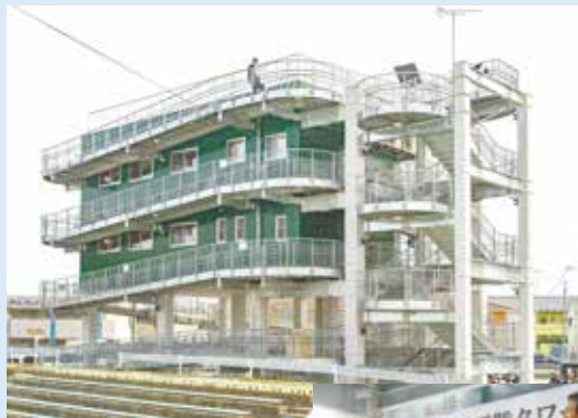
△完成した津波避難タワー
